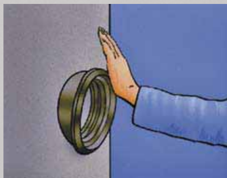
Press i Forsheda 910 i hullet.
