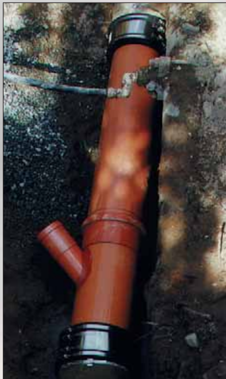
Bilde: Rett kobling (SC) og foring (BC) brukt for å lage overgang mellom 9" betong og 250 mm Ø PVC.
